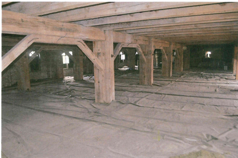
Bild 1. Hölzerne Tragkonstruktion eines Lagergebäudes aus dem 19. Jahrhundert, die Instandsetzung erforderte die Festigkeitssortierung des verbauten Holzes Fig. 1. Wooden support structure of a warehouse from the 19 th century, the redevelopment required the strength grading of the obstructed timber
